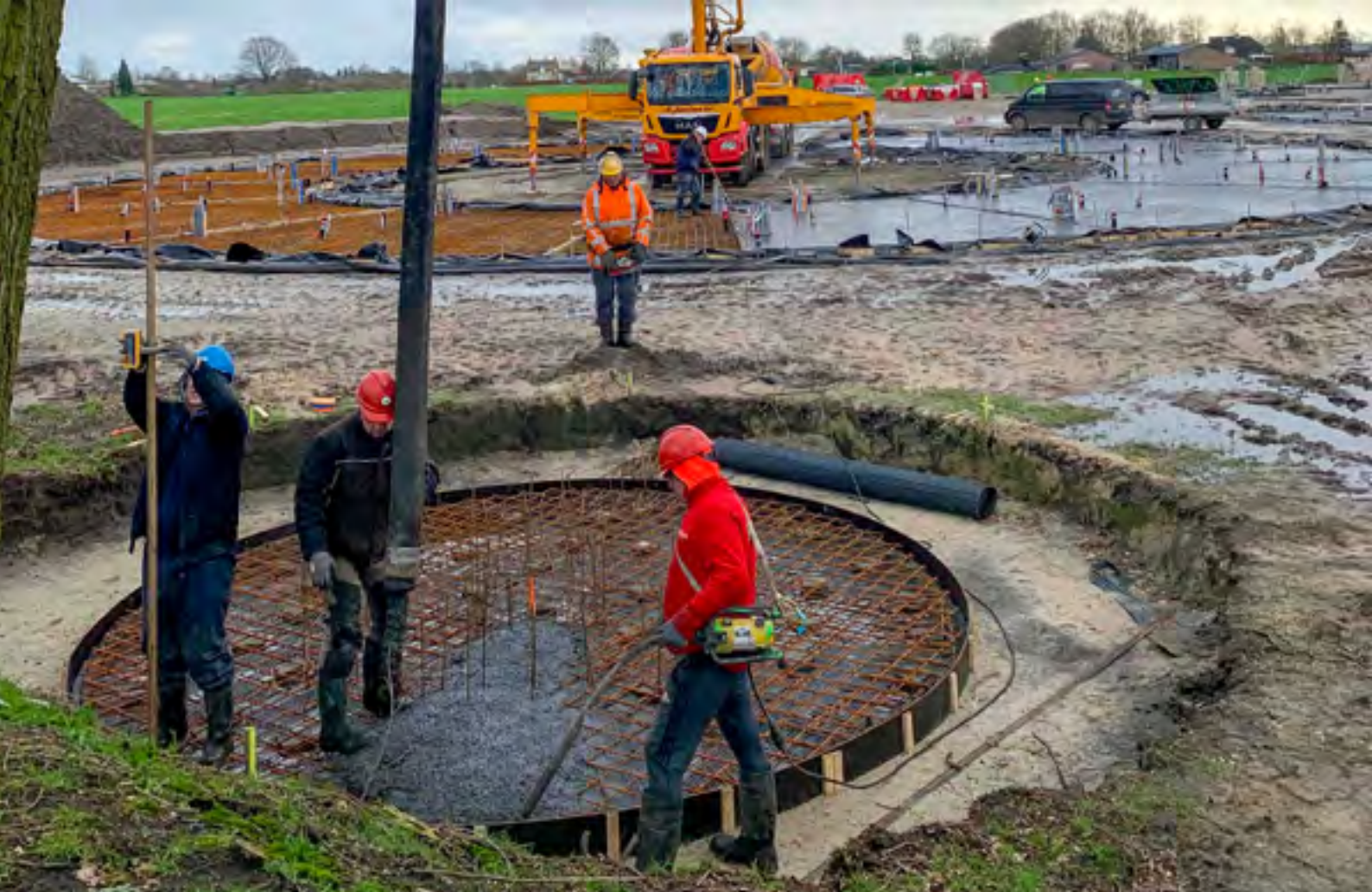
Fundaties met gewapend geopolymer als vervanger van cement.
