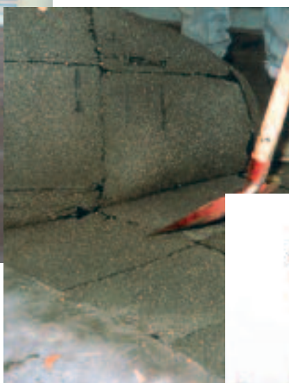
Verwijdering bitumineus dakleer.
