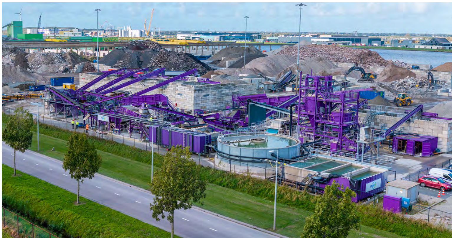
Renewi locatie Amsterdam Westpoort Naast grind wordt hier ook zand teruggewonnen en gerecycled voor de betonindustrie.
