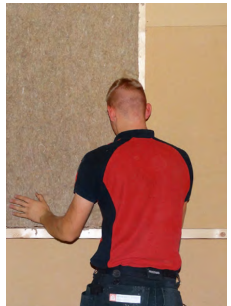
Het isolatiemateriaal van vezelhenep toegepast in een woning.
