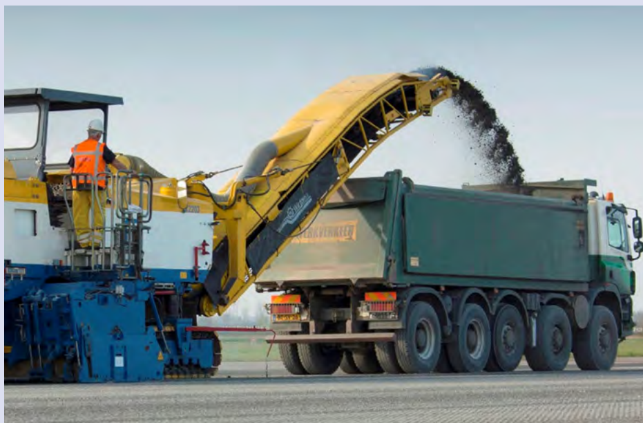
Selectief verwijderen van asfalt
